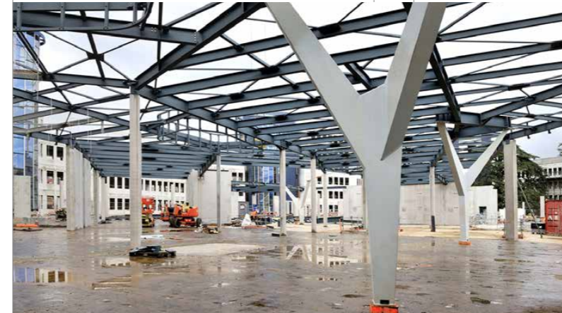
Création d'une charpente métallique de 300 tonnes et 13 000 pièces. Au total, 6 poteaux-arbres soutiennent la toiture. Demain, le toit du hub sera entièrement végétalisé.
